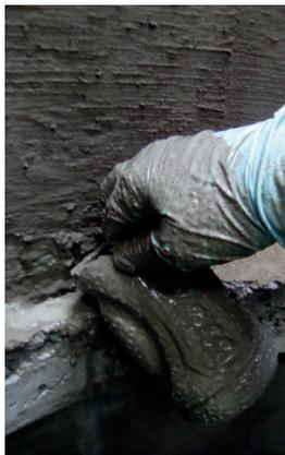
10. *Detalhe do preenchimento das frestas entre os anéis. Foi utilizado uma garrafa de plástico para distribuir a argamassa niveladora*
