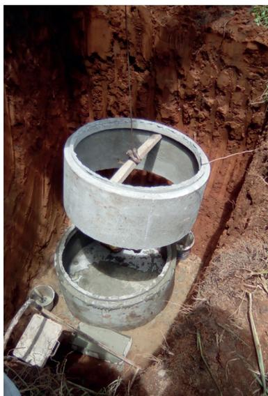
7. Anéis de concreto sendo posicionados com o auxílio de uma máquina
