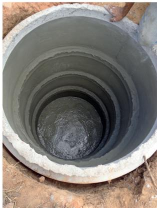
9. *Tanque séptico com o fundo concretado e espaço entre os anéis preenchido*
