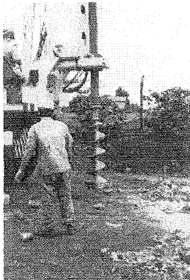
Figura 5.1- Trado – Estaca Escavada.
