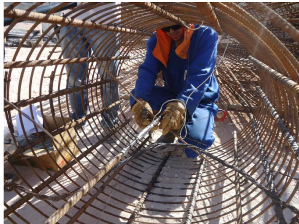
Figura 8. Barra instrumentada no eixo do tubulão. Fonte: Engeobase (2013)
