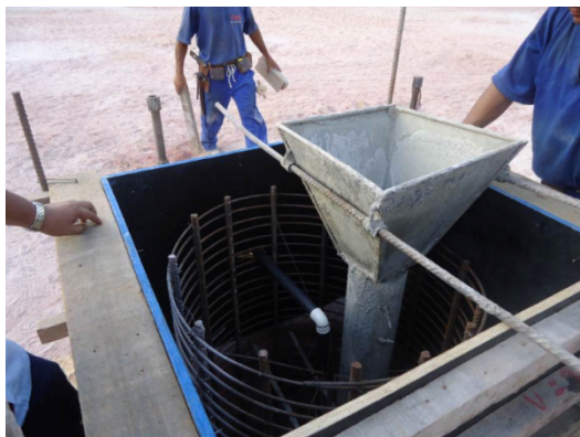
Figura 9. Concretagem do tubulão instrumentado. Fonte: Engeobase (2013)
