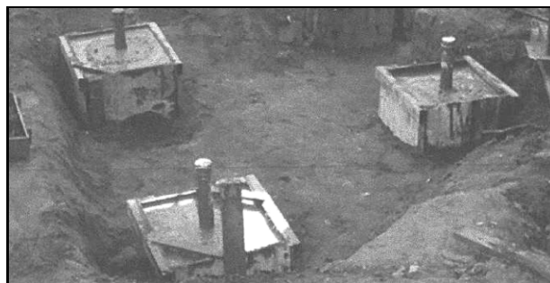
Figura 2 Vista geral das estacas ensaiadas.
