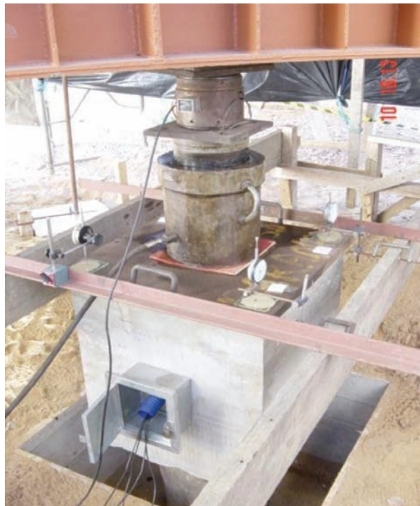
Fig. 3 – Detalhe da montagem da prova de carga.
